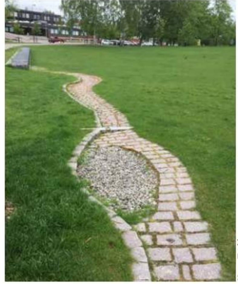
R3 Käyttöviheralue, imeytyskaivanto, Kirjastopuisto, Vantaa.
