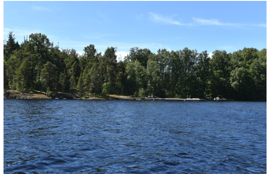
Kuva: Retkikeskuksen laituri pojju paikoin ja saunarannan laituri ovat korjaustoimenpiteiden kohteena kesällä 2024. TA
